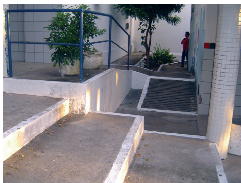
Foto 2: Rampas de acesso
